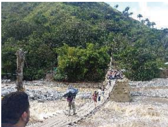
Puente provisional instalado por la comunidad
