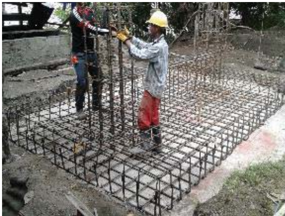
Construcción de muro en concreto reforzado
