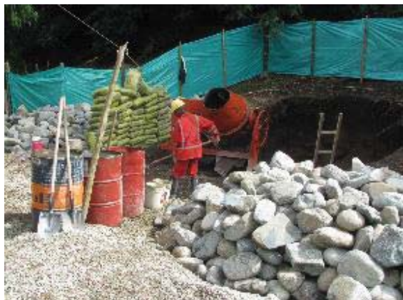
Construcción de cimentación en concreto ciclópeo
