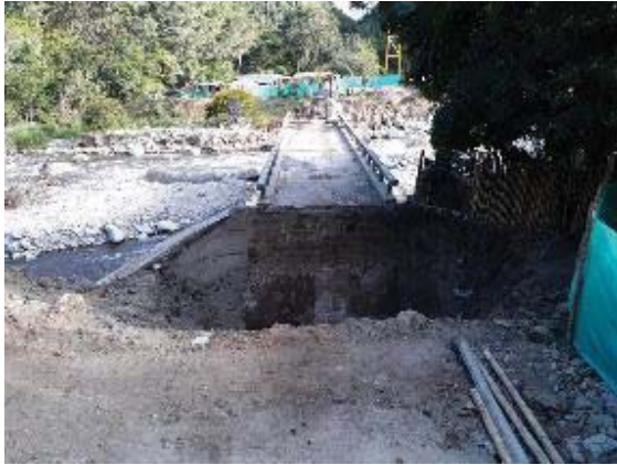
Replanteo y excavación para cimentación M.I.
