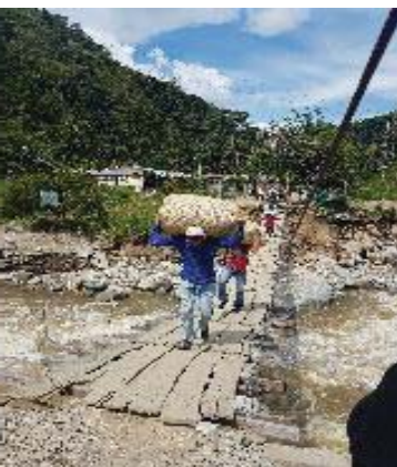
Presencia constante usuarios del puente-hamaca
