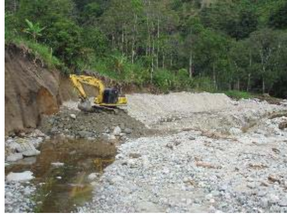
Dragado del cauce y protección de la margen
