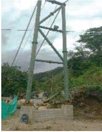
Construcción de muro en concreto y pórticos
