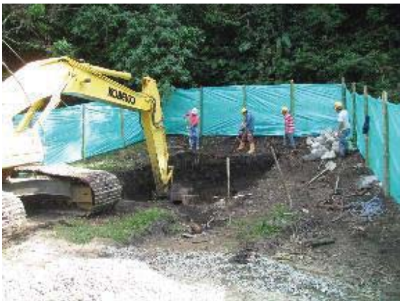
Excavación para cimentación
