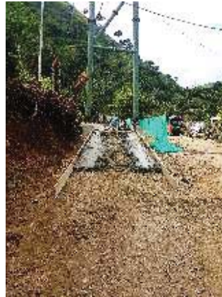
Construcción de accesos puente peatonal
