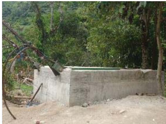
Construcción de macizos de anclaje
