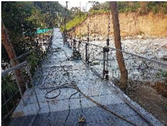
Instalación de barandas puente peatonal
