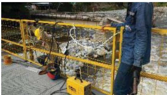
Ajustes y retoques del puente peatonal
