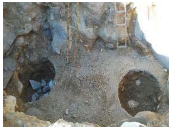
Excavación anillos caisson margen derecha (M.D.)
