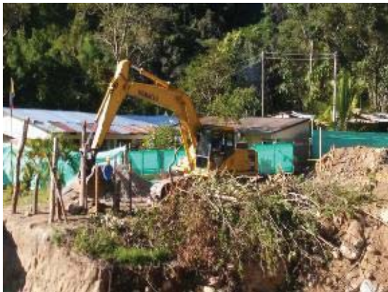
Excavación para cimentación margen derecha
