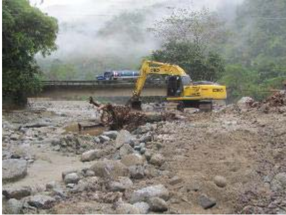
Remoción de material que generó la emergencia
