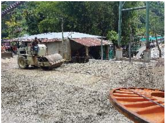
Relleno y compactación accesos puente peatonal
