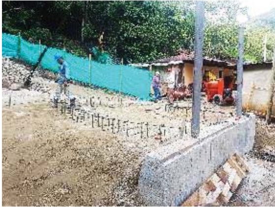
Construcción de accesos puente peatonal
