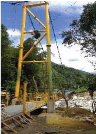
Pintura de pórticos y barandas del puente peatonal
