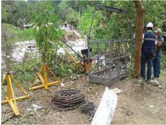
Instalación de tarabita para trasiego de material
