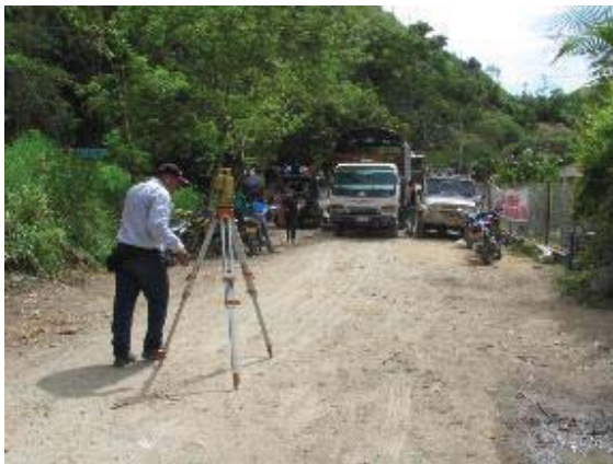
Localización y replanteo
