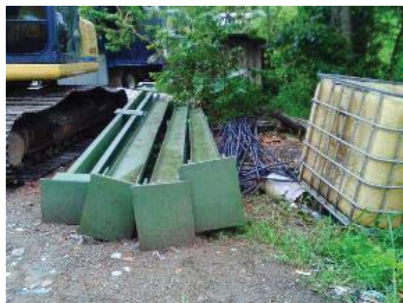
Suministro estructura metálica montaje puente
