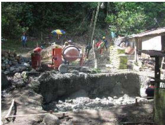
Construcción de cimentación concreto ciclópeo
