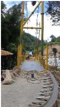
Construcción de acceso peatonal en concreto
