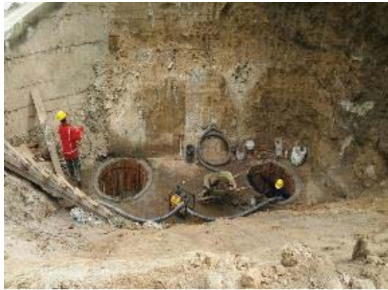
Excavación y aplicación concreto anillos caisson
